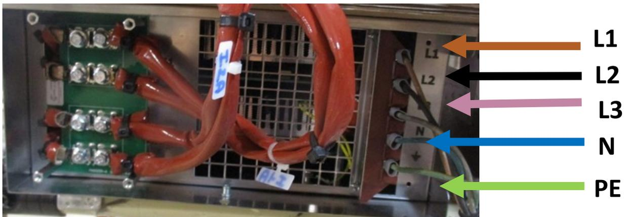
Lorsque les 5 conducteurs équipés d'embouts de câblage sont raccordés au bornier et que les 5 vis de serrage du bornier sont correctement serrées, il faut remettre en place le capot de protection avec ses 2 vis de fixation.
